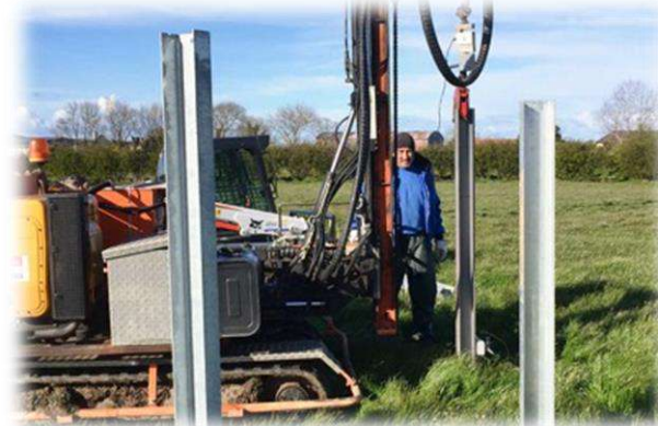
Exemple de batteuse de pieux (source mkg-goebel.de)
