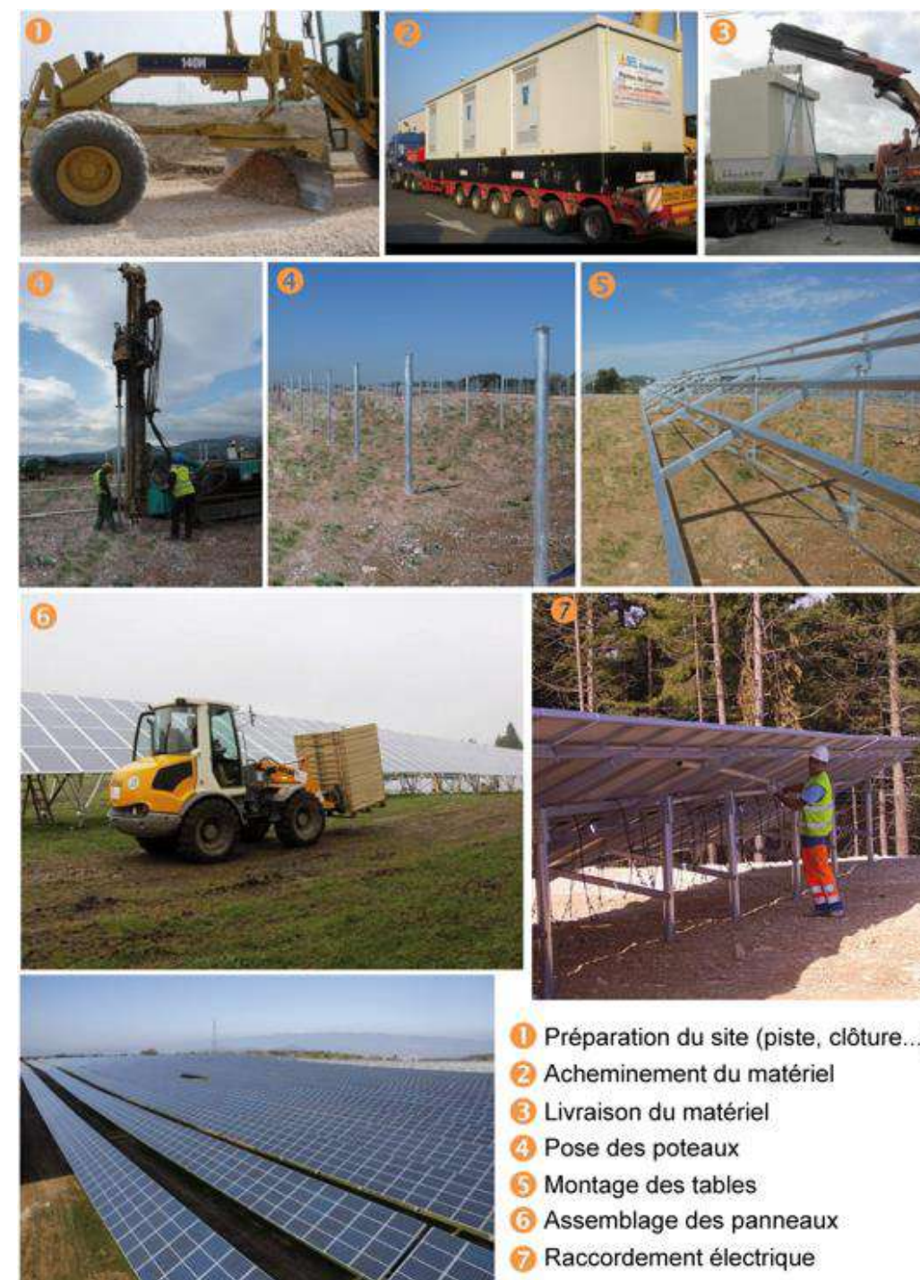
Illustration 30 : construction d'une centrale photovoltaïque
