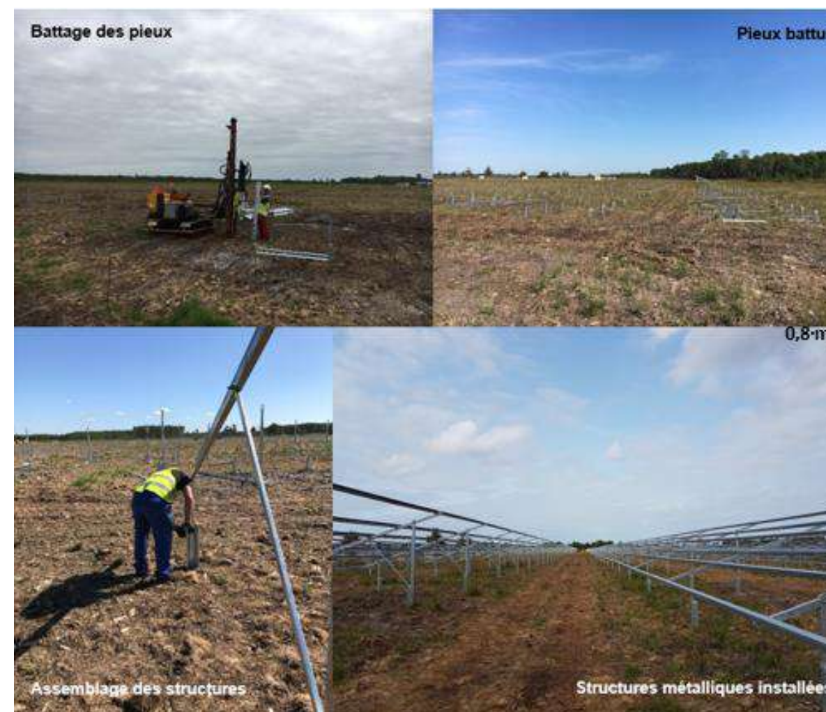
Illustration 12 - Ancrage au sol par pieux battus
