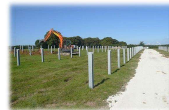
Exemple de voie d'accès en matériaux concassés
