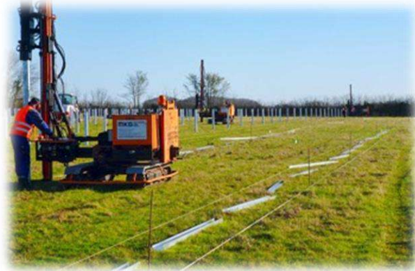
Exemple de batteuse de pieux (source mkg-goebel.de)
