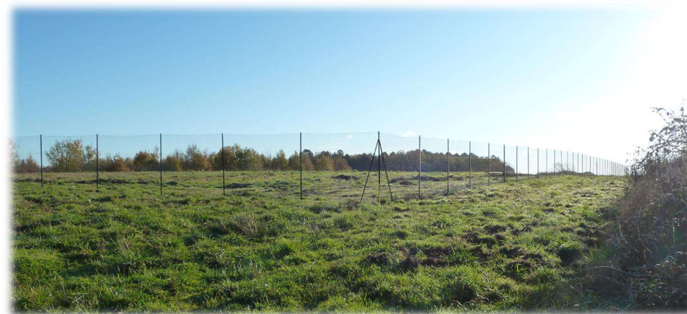
Clôture du parc photovoltaïque en construction en limite de l'AEI
